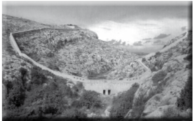
Il-Victoria Lines f' Wied Faham, il-Għargħur wiehed mill-isbaħ eżempji li baqa bħala linji.
