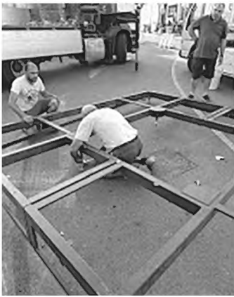
Waqt li kien qed jintrama fil-post il-ħadid ta' diżlivell
