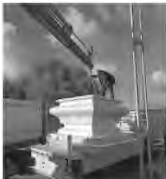
Jibdw jinhattu l-partijiet tal-pedestall biex jiġi armat għall-ewwel darba
