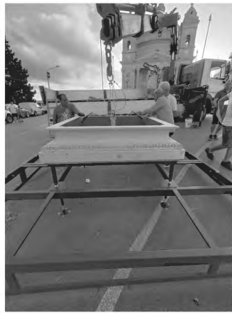
Id-diżlivell issettjat fil-post, qabel ittiebed lejn Ghawdex biex jinkesa bl-injam u jinzebagħ
